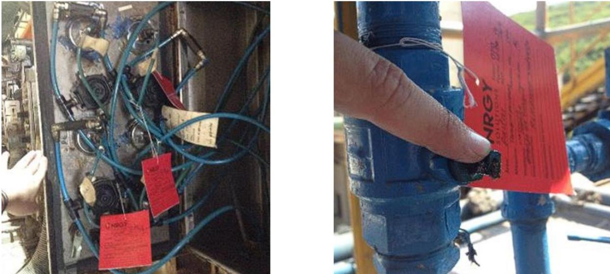
Figura 1. Ejemplo de testigo visual y fotografías de fugas de aire comprimido identificadas.
