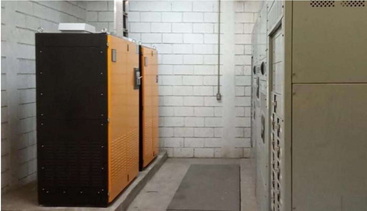
*Figura 1. Filtros de armónicas automáticos en baja tensión para corrección de FP.*
